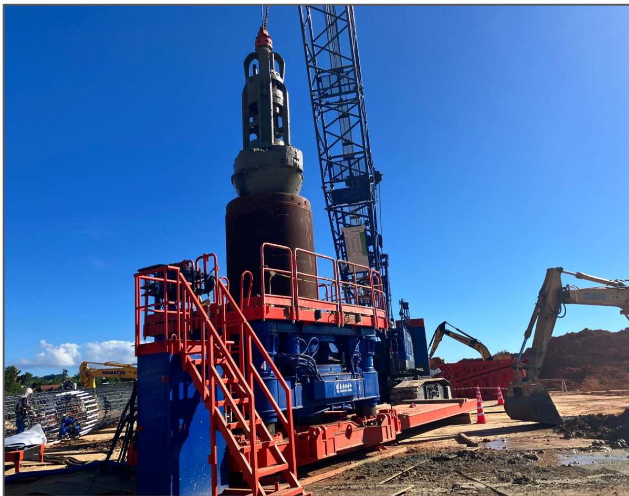
～杭工事の様子（令和8年7月）～
